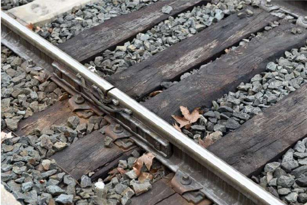
Contrôle des éclisses (écarts entre deux rails) [5]
